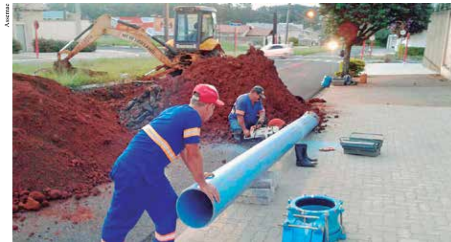
Serviços públicos permitem melhorar sistema, pois o foco é social e não o lucro, defende Assemae. Obra do Departamento Autônomo de Água e Esgotos (Daae) de Araraquara (SP).
