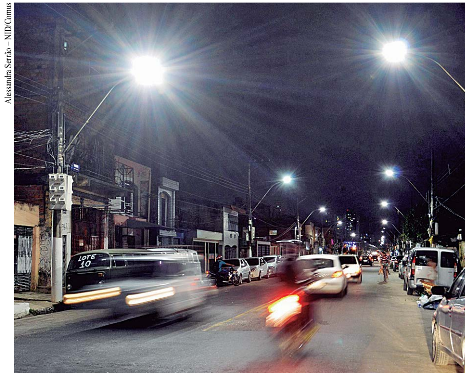
Nova iluminação pública na Avenida Alcindo Cacela, em Belém (PA).
