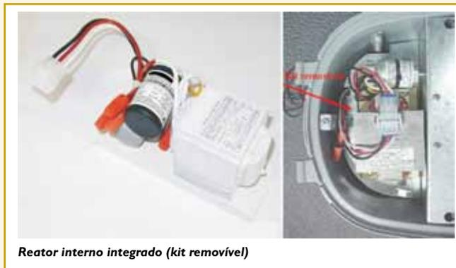
**Reator interno integrado (kit removível)**
