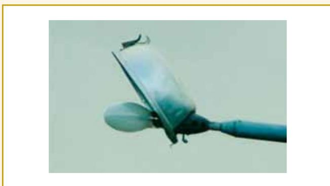
**Figura 3 – Luminária deteriorada**
