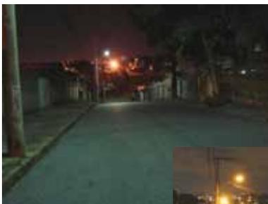
Antes, a utilização de lâmpadas a vapor de mercúrio de 80 W em luminárias abertas e após a substituição por lâmpadas a vapor de sódio de 70 W em luminárias fechadas.
