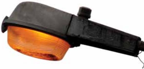
Falha no relé fotoelétrico deixa a lâmpada ligada durante o dia
